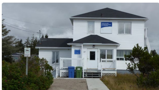
Le CISSS de la Côte-Nord a récemment annoncé la construction d'un nouveau dispensaire à Natashquan. PHOTO: Graciusseté - Pascal Paradis / CISSS Côte-Nord
