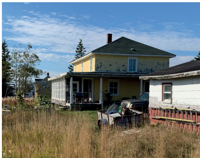
Vue de biais de l'arrière du bâtiment
