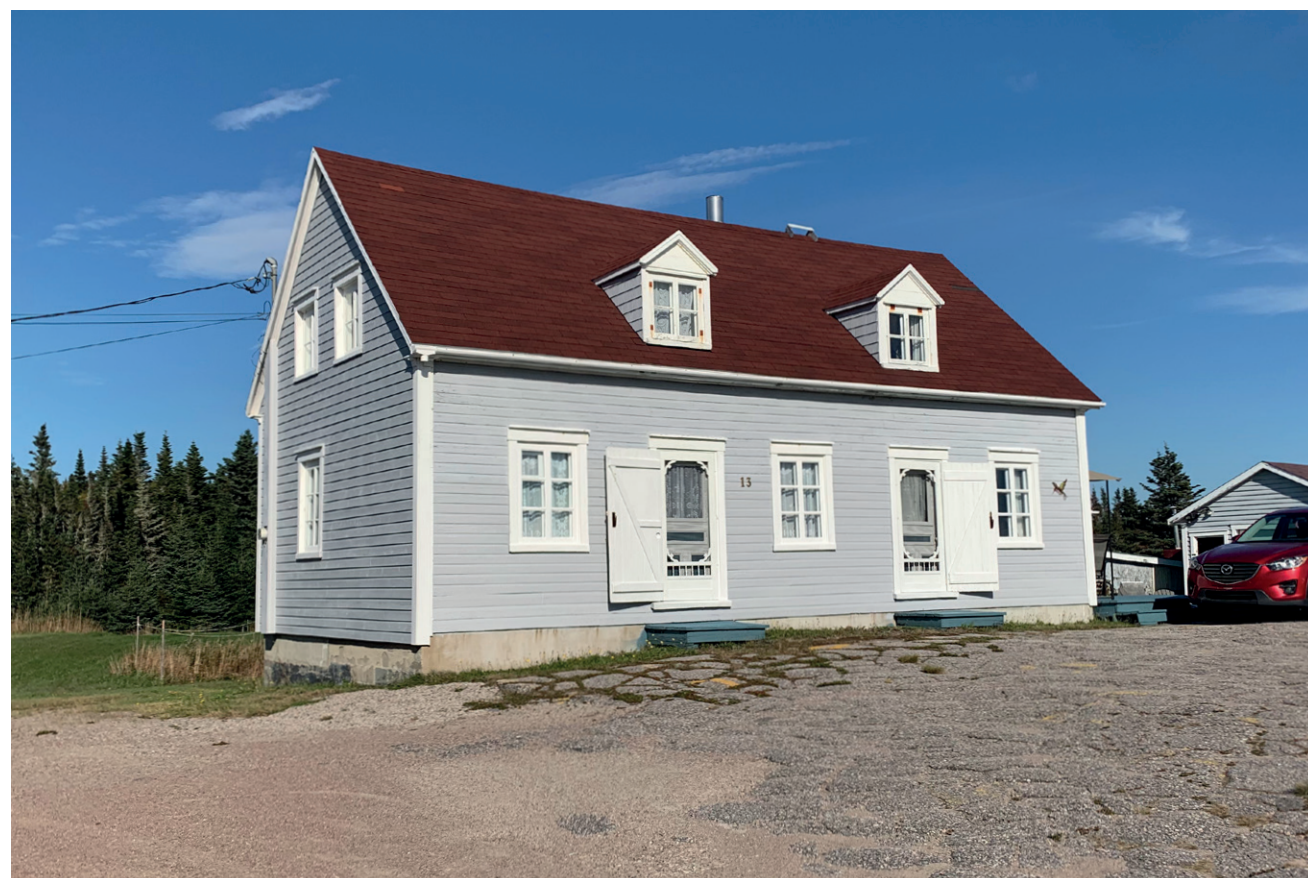
Vue de biais de la façade principale
